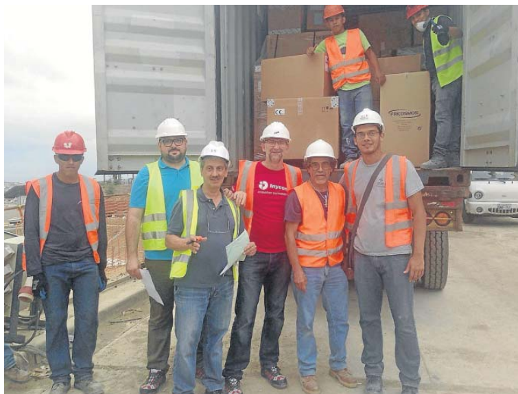
Personal de Inycom, descargando material para el nuevo hospital de Guayaquil. INYCOM
